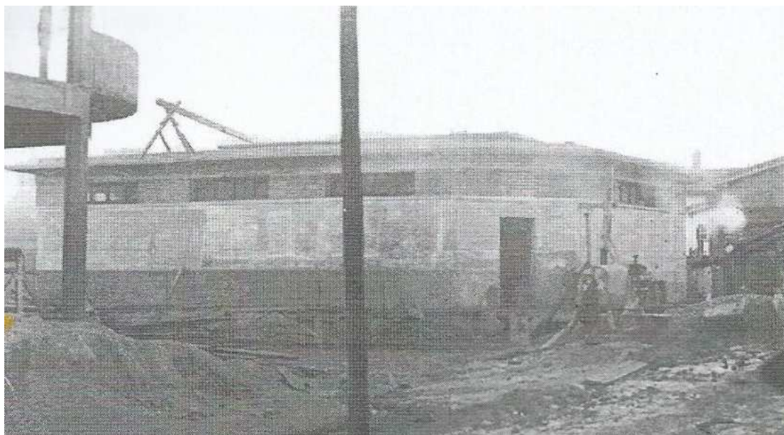
Lavadero (13-12-1943) con la carretera de la calle Andikollano en obras
